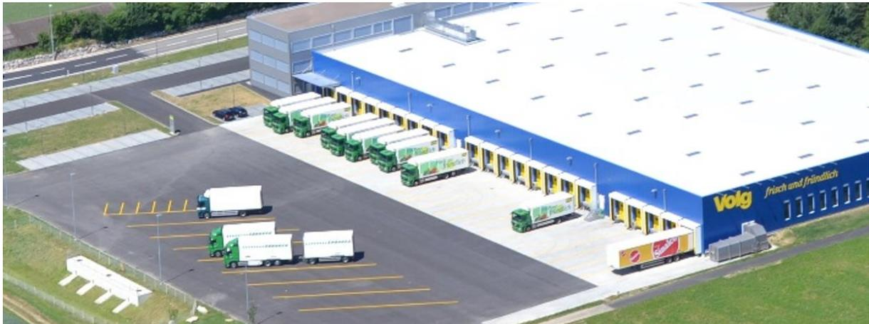
Abb. 9 Beispiel Eingangsrampen LKW beim bestehenden Lager in Oberbipp
